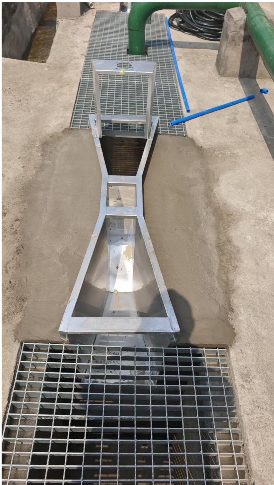
图 4.1-4 一化、二化循环冷却水排放口
