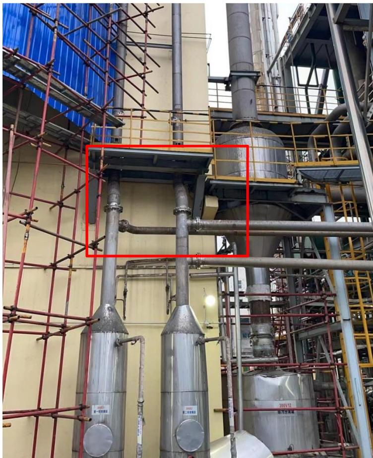
图 4.1-8 一化中间缓冲罐废气排放口 DA029 采样口及采样平台
