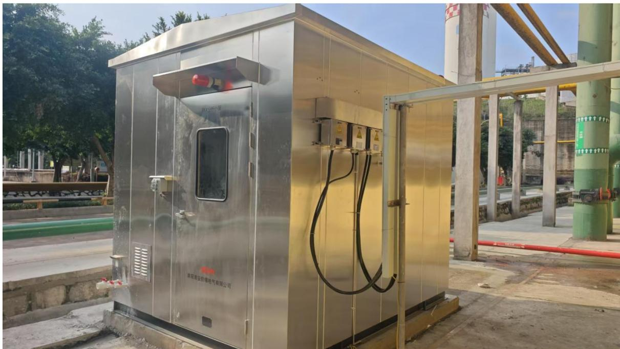
图 4.1-3 一化、二化循环冷却水排放口在线监测房
