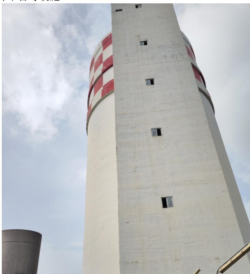
图 4.1-6 一化造粒废气排放口 DA007
