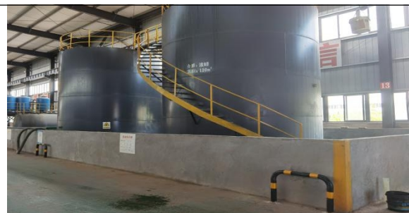
罐区内已做防腐处理
