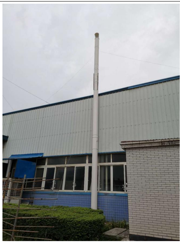
破碎废气排放烟囱
