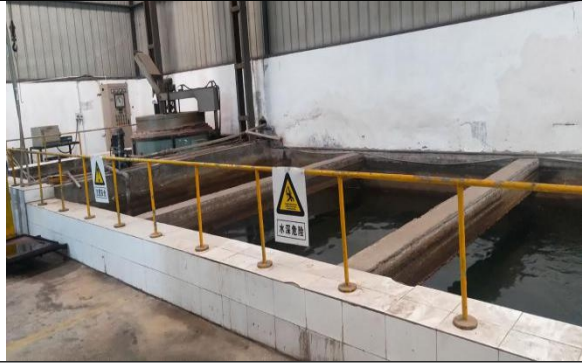
循环冷却水池
