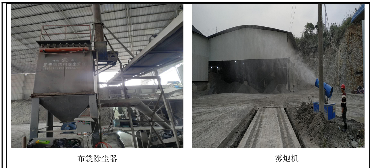
图 3.2 废气处理设施图
